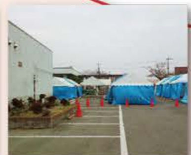
震災直後の筑西市民病院の様子
